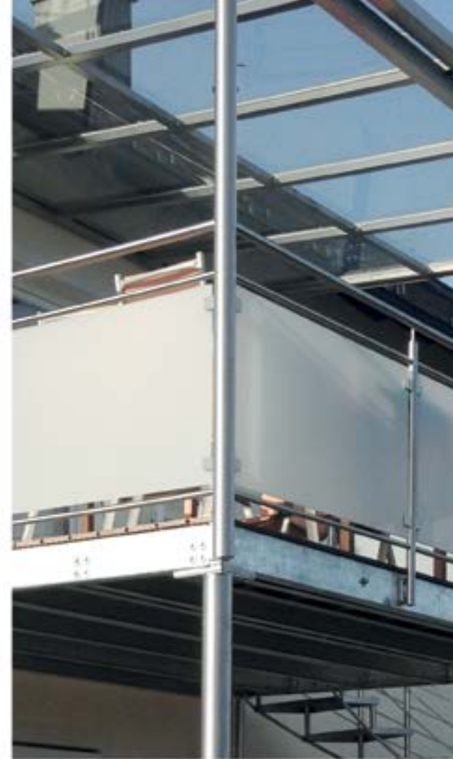
Edelstahlgeländer mit Glas für Balkonzubau aus Stahl
